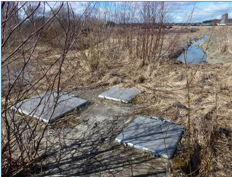
Figur 14. Oljeavskiljaranläggningen norr om Hamre ÅVC. Foto Böril Jonsson.
